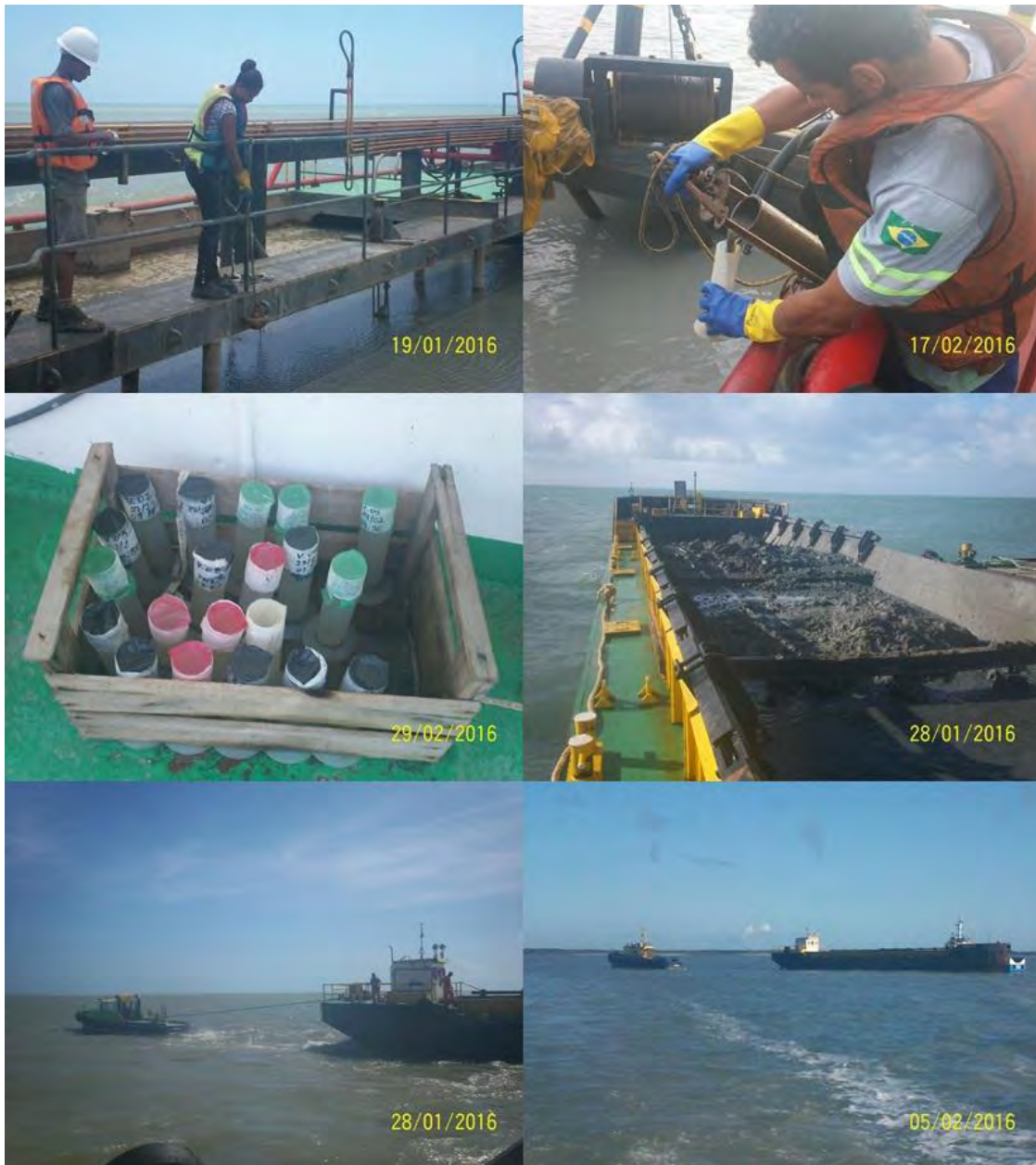
Figura 18: Uso do prumo e da proveta para medir o volume dragado. Batelão carregado com sedimentos. Transporte do batelão para a área de descarte.
