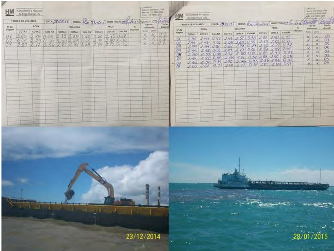
Figura 25: Planilhas de registro das viagens da draga; equipamentos de dragagem operando no canal do Tomba.
