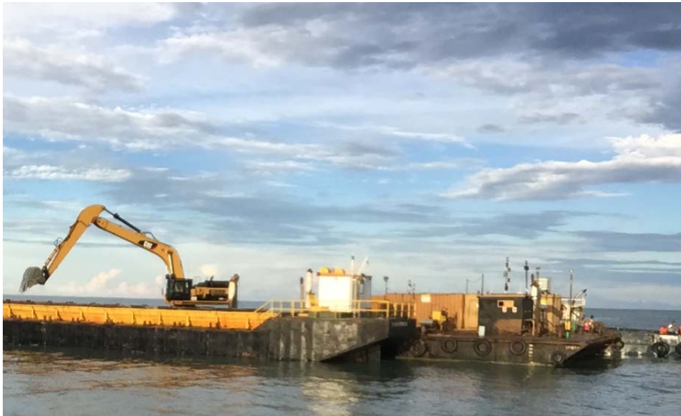
Figura 4-2 – Escavadeira a bordo da balsa Spot realizando carregamento no batelão Tucuruí
