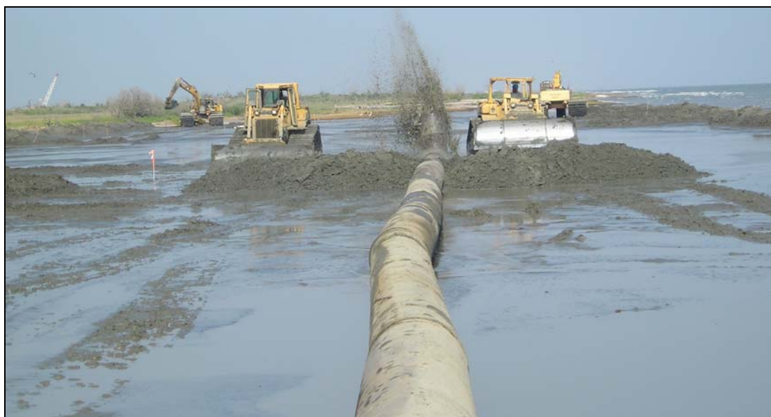
Figura 4.2-4: Operação de descarte de material numa praia localizada na Lousiana (EUA). Cerca de 1 milhão de metros cúbicos de sedimentos foram descartados.
