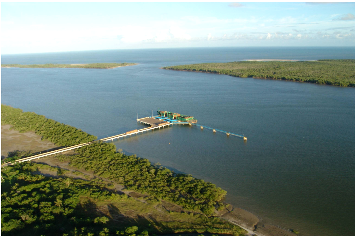
Figura 3.1.2-3 – Vista geral do terminal de Barcaças em 2005
