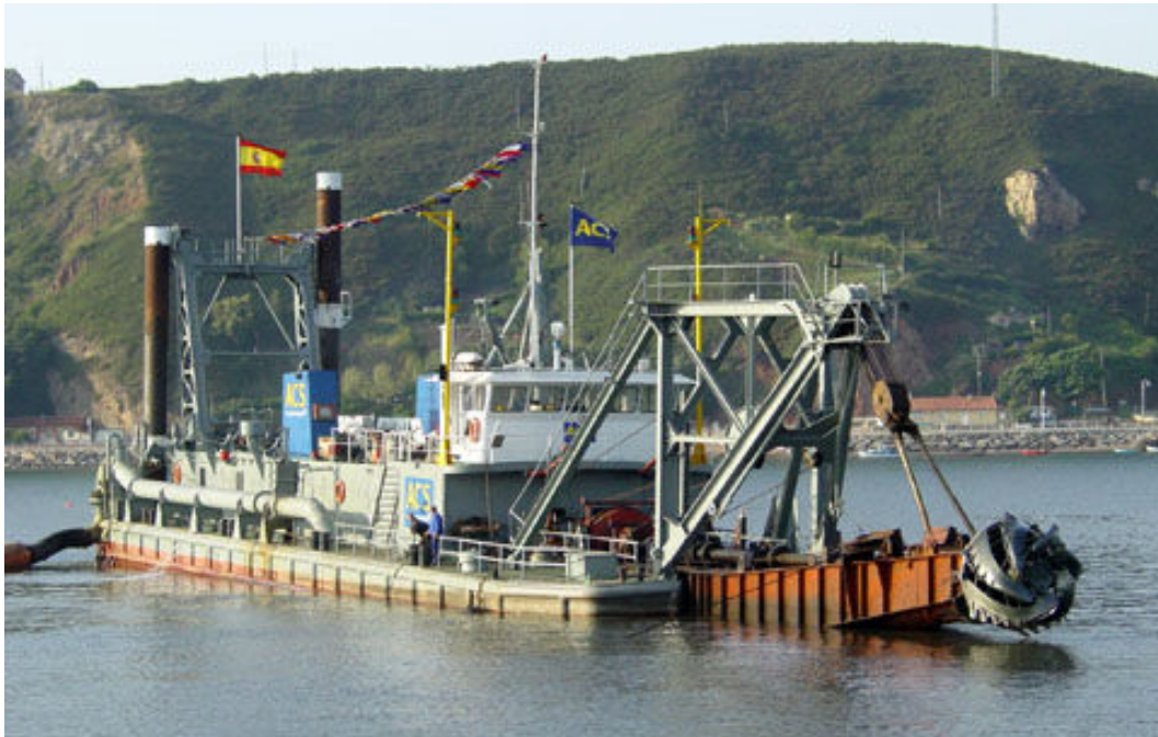
Figura 3.6.4-8 – Draga de sucção e recalque Antea equipada com desagregador (cutter suction dredger), dragando no Porto de Avilés, Espanha
