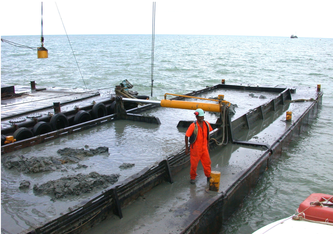
Figura 3.1.3-14 – Batelão carregado de sedimento pelo clamshell na 1ª Campanha de Dragagem
