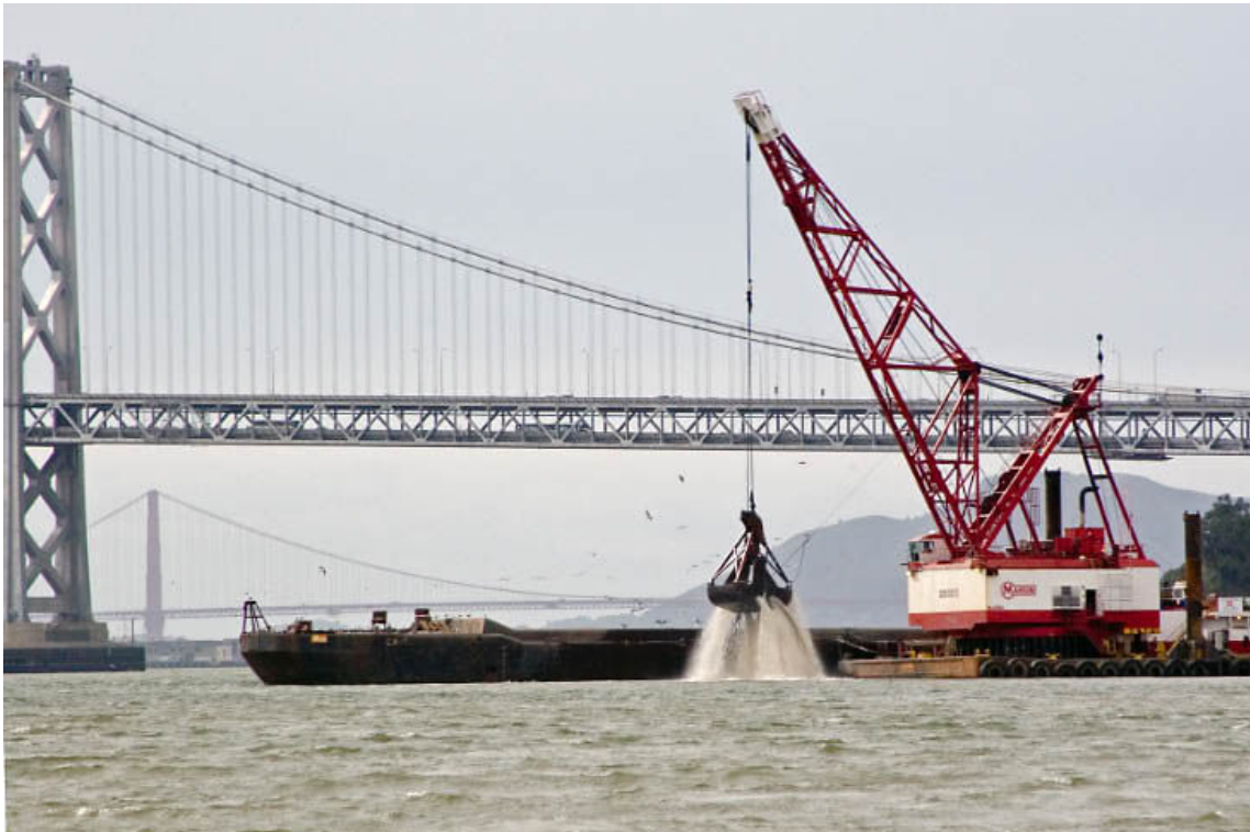
Figura 3.6.4-1 - Draga de caçamba em operação - Baía de São Francisco, EUA
