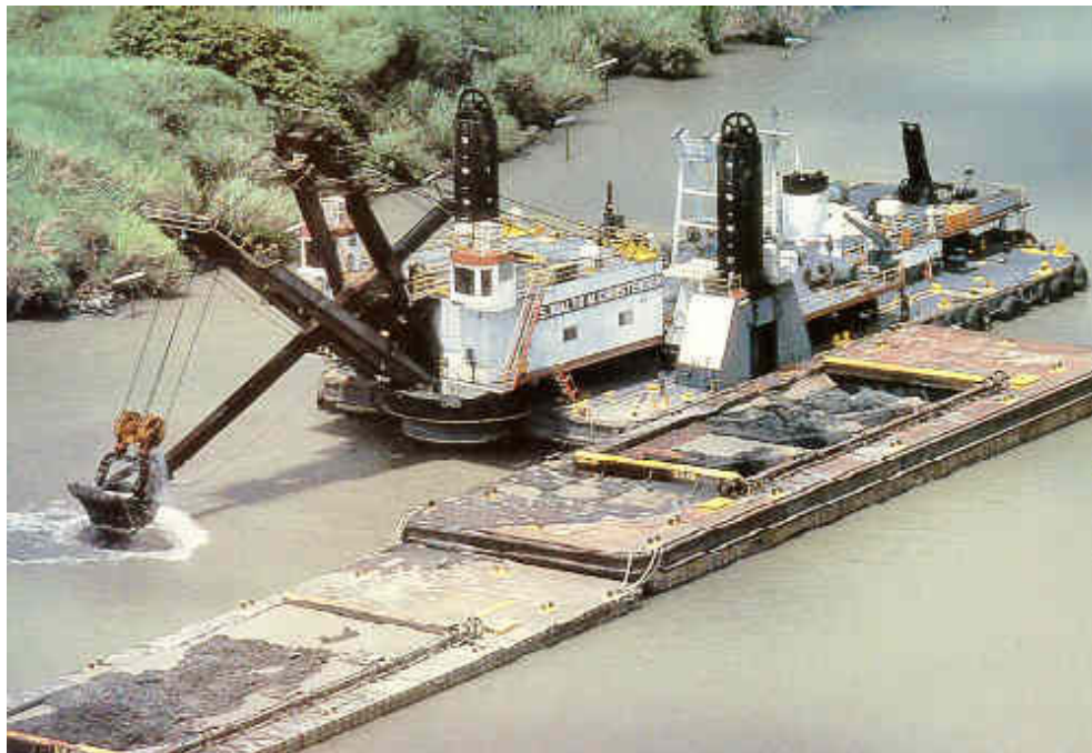
Figura 3.6.4-2 – Draga mecânica tipo escavadeira
