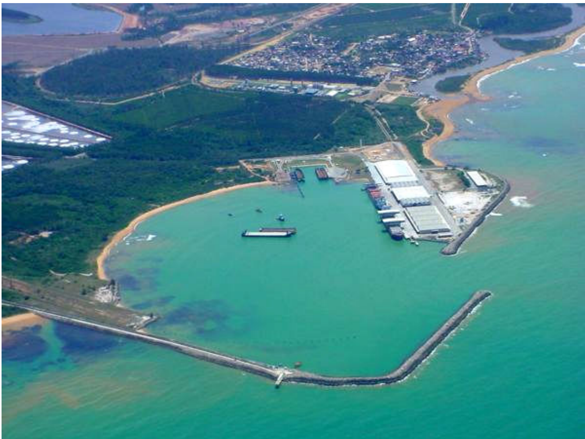
Figura 3.1.7-1 – Vista geral do Porto Organizado de Barra do Riacho
