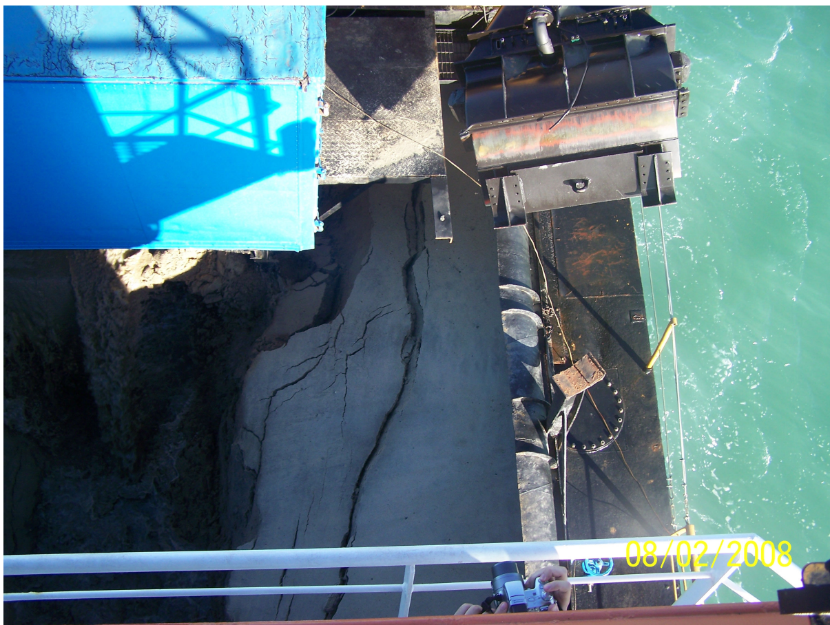
Figura 3.1.3-27– Carga sendo despejada pela Draga Virgínia - 7ª Campanha de Dragagem
