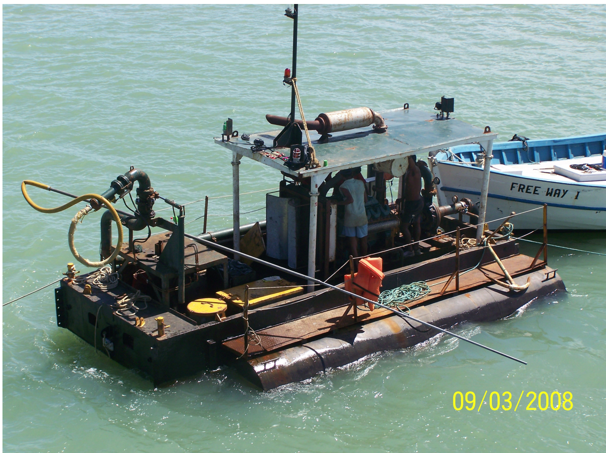
Figura 3.6.4-14 – Flutuante F4 equipado com desagregador hidráulico
