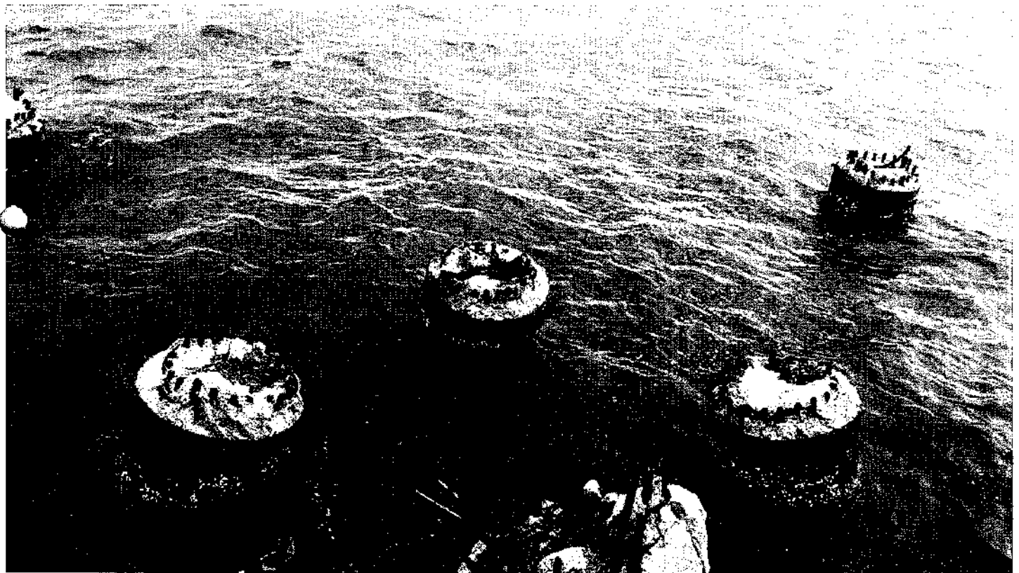
Figura 33: Permanência da fundação de dolphin antigo
