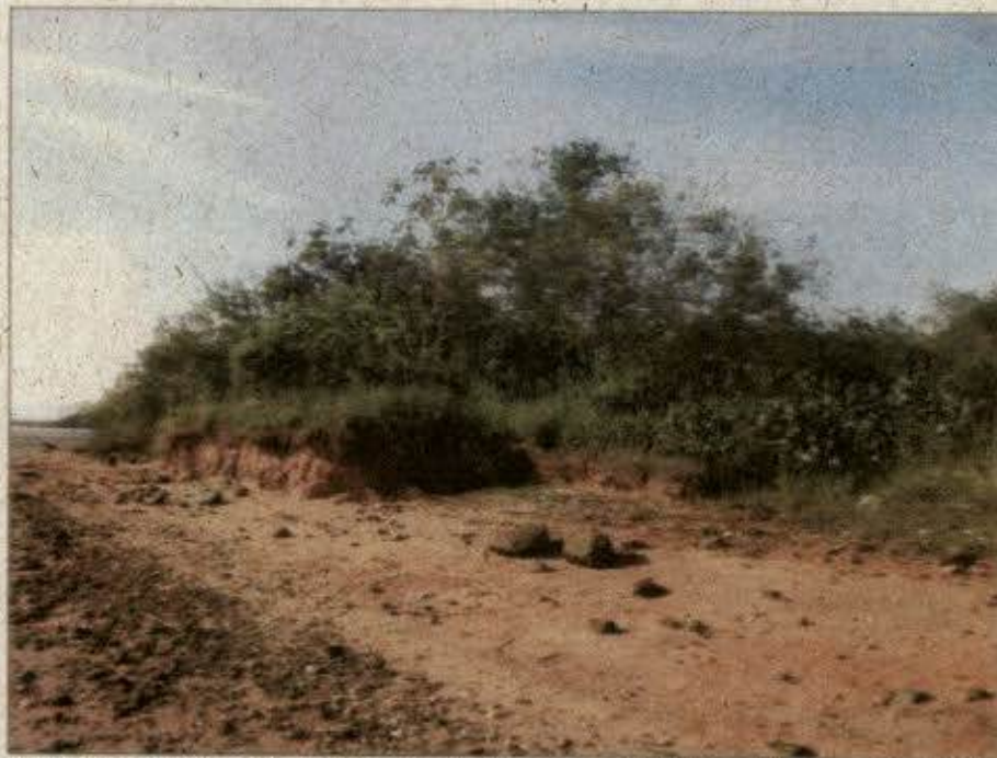
Figura 1. Destaque da área de borda construída por terreno (solo) de origem antropogênica (aterro continental) sofrendo processo de erosão.
