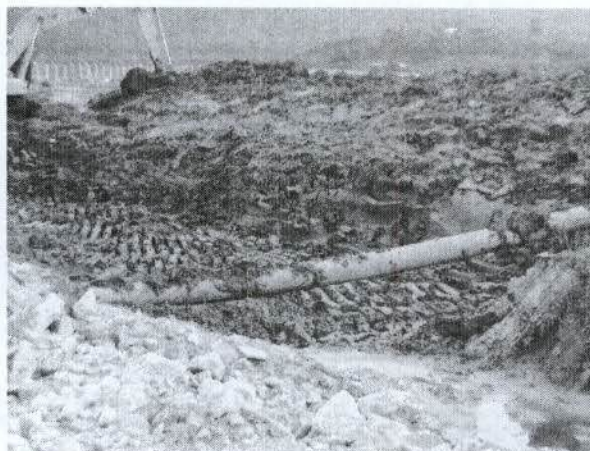
Figura 57 – Obra de construção de estacionamento
