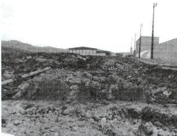
Figura 55 – Obra de construção de estacionamento
