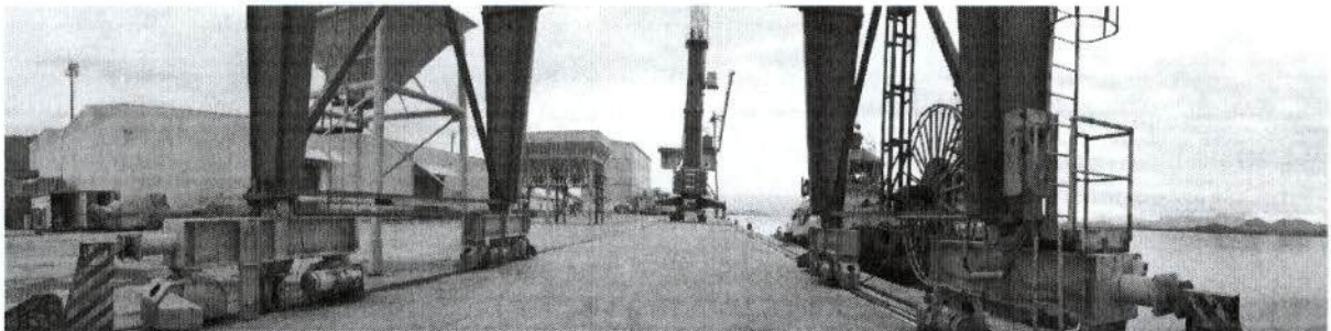
Figura 36 – Vista geral do TPPF
