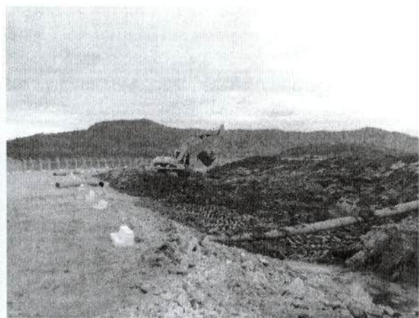
Figura 56 – Obra de construção de estacionamento
