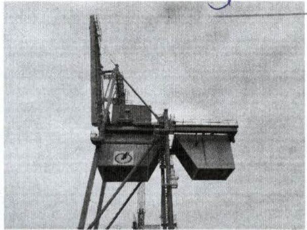
Figura 32 – Instalações do TPPF (Pallet bridge)
