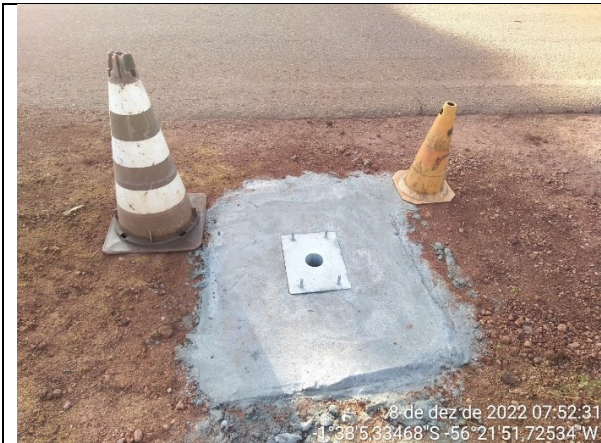
Figura 3.7 - 9 Etapa de instalação da lombada
