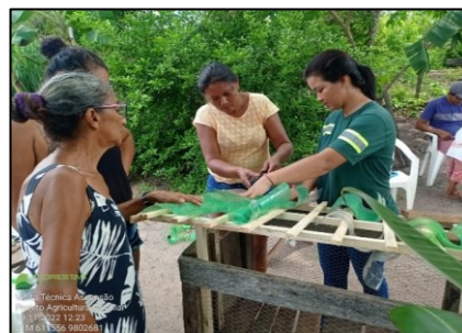
Confecção do telhado do pinteiro utilizando garrafa pet durante visita técnica de novembro na comunidade Ascensão
