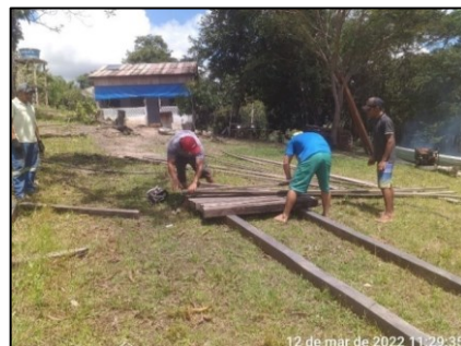
construção dos tanques flutuantes na comunidade Bacabal
