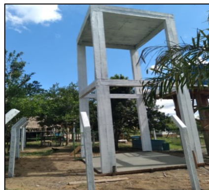
Construção da torre de concreto para microsistema na comunidade Saracá
