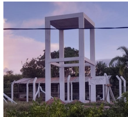
Construção da torre de concreto para microsistema na comunidade do Batata
