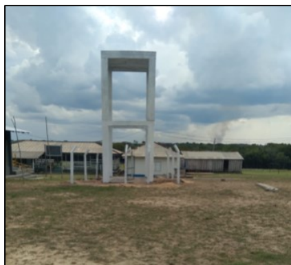
Construção da torre de concreto para microsistema na comunidade Boa Nova
