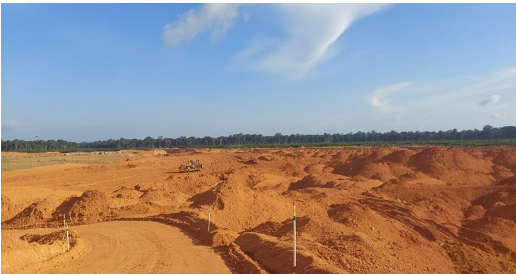
Figura 2.4 - 10 Área quebra de pilha em operação.
