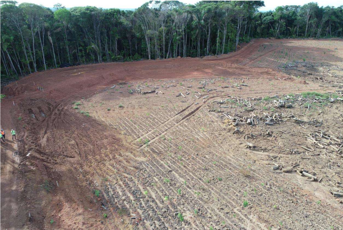
Figura 8: Alteamento da encosta.
