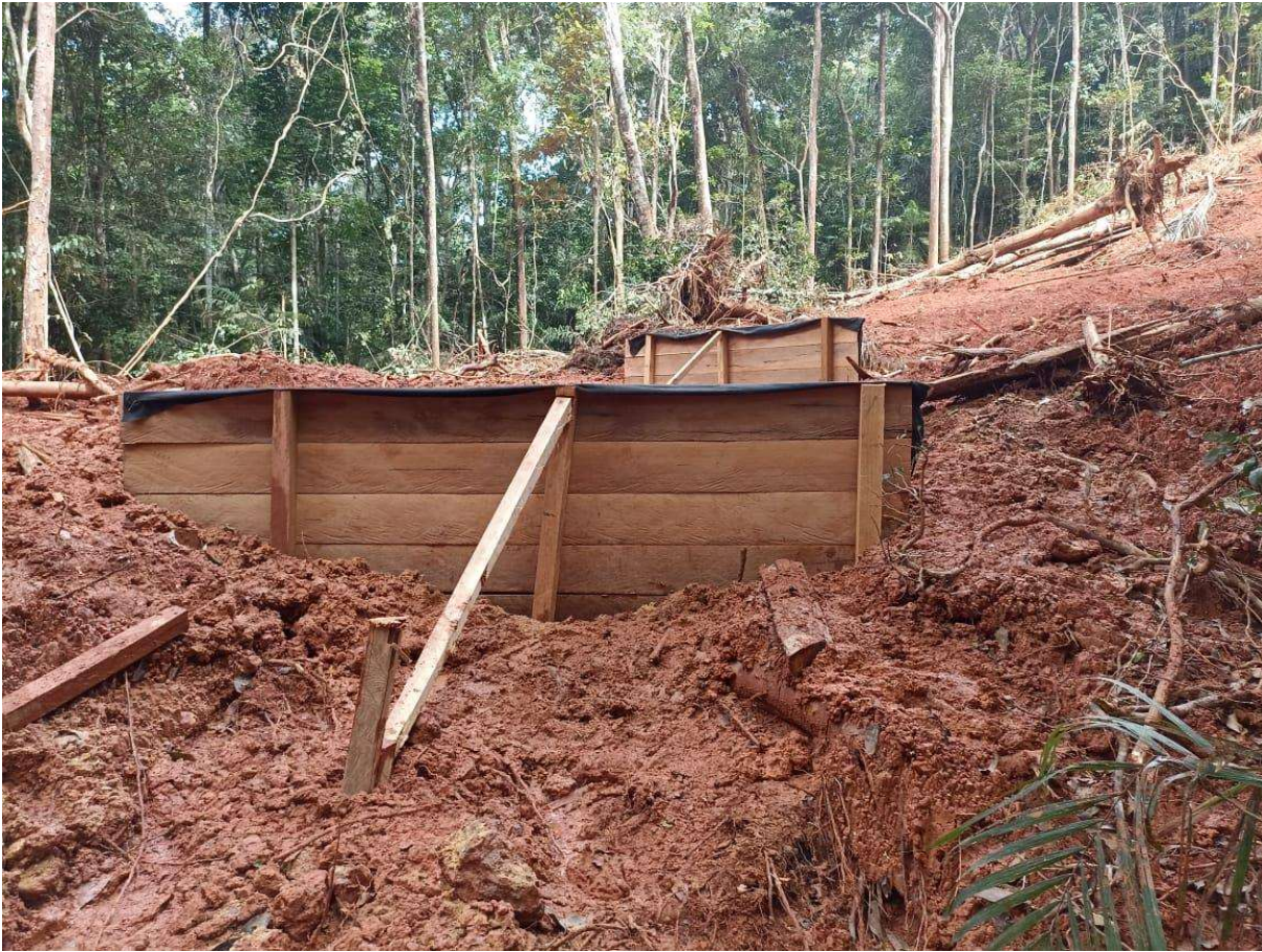
Figura 12: Barreiras próximas à encosta.
