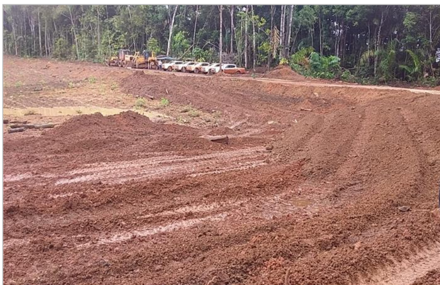
Figura 5: Alteamento da encosta.
