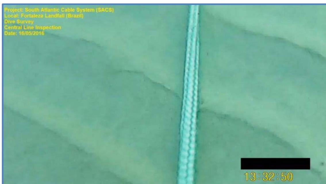
Figura 3.3. - Imagem do Mergulho - linha central, Ilustrando terreno ondulado.
