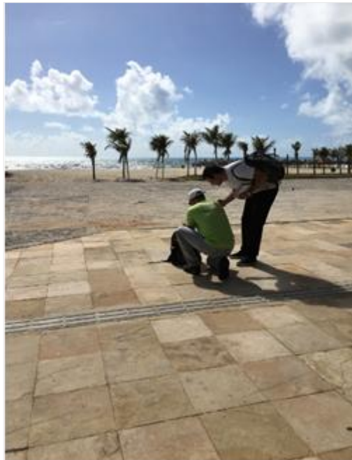
Figura V.2.2-1. Foto tirada no local de instalação do Beach Man Hole (BMH) proposto evidenciando o perfil da Praia do Futuro, Fortaleza, Ceará.
