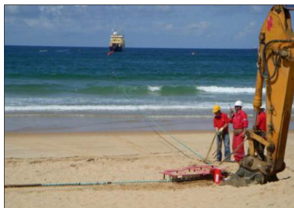
Figura III.2.2-3. Escavadeira ancorando quadrante para permitir que o cabo faça giro de 90 graus na praia.
