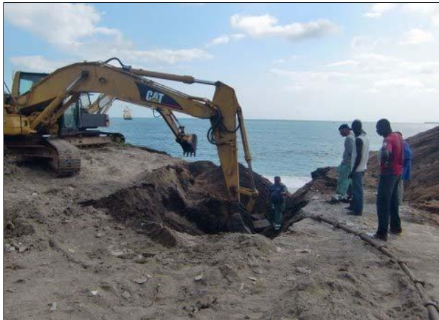
Figura III.2.2-4 Enterramento do cabo na praia.
