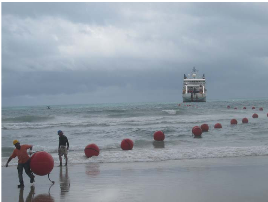
Obra na praia
