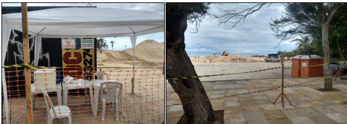
Figura 341 – Área isolada em toda a extensão da obra
