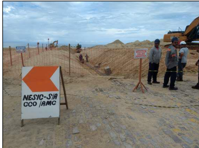
Figura 339 – Trabalhadores utilizando EPI's, durante as atividades em campo
