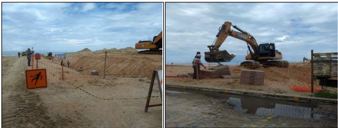
Figura 340 – Área isolada em toda a extensão da obra
